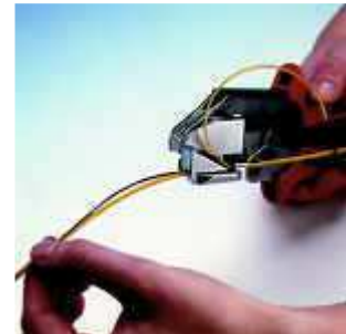
Anschneiden der Bündelader
